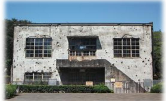
…市は、平成29年度にこの変電所の現地調査を委託により実施。建物の状態などを調査した結果報告書を受けて、『耐震補強方針』を“一般的な建物の耐震基準には適合できないので、既存不適格建物の特例として認められている「構造上危険性が増大しない構造補強設計」として工事を行う”ことと決定し、その方針に沿って基本方針を策定していましたが、今年度の改定では「変電所内部の公開を前提とするため」①耐震補強の検討と②現在の状態での保存をより優先させることとしました。
