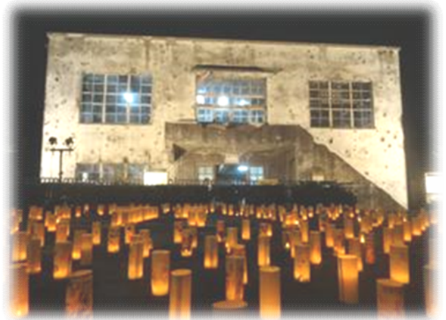
【『平和市民のつどい』の平和祈念キャンドルと変電所】
