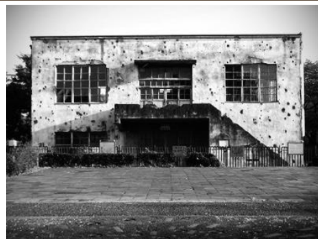
【3回の空爆による沢山の銃弾の跡が残る変電所】
